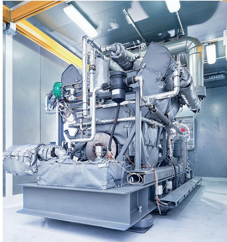
Das Herz der ORC-Anlage: der Zwölfzylindermotor zur Stromerzeugung
