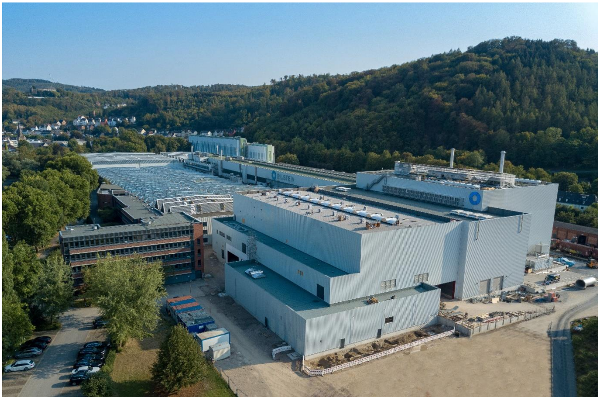
Bild 1: Neubau Breitbandwalzwerk, BILSTEIN Werk I (Copyright BILSTEIN GROUP)
