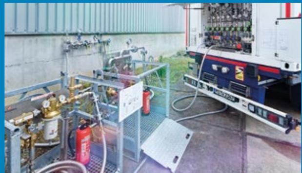
Die Westfalen AG konnte die für den Praxistest geforderte Menge und entsprechende Lkw-Trailer bereitstellen, aus denen der Wasserstoff direkt in die Rohrleitungssysteme der Haubenglühe geleitet wurde.
