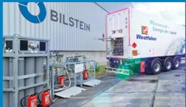
Wird Wasserstoff anstelle von Erdgas als Energieträger verbrannt, braucht man die dreifache Menge, weil der Heizwert so viel niedriger ist. So waren anstatt 1 870 m<sup>3</sup> Erdgas ca. 5 600 m<sup>3</sup> Wasserstoff notwendig, um die rund 100 Tonnen Kaltband mehrere Stunden bei einer Temperatur von 710 °C zu glühen.
